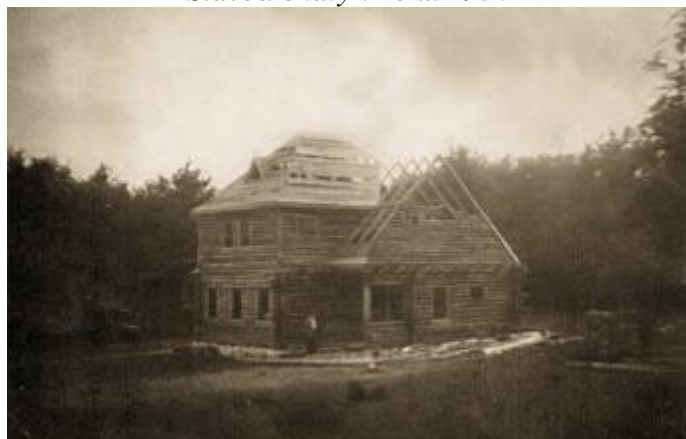
Stavba chaty v roku 1936
